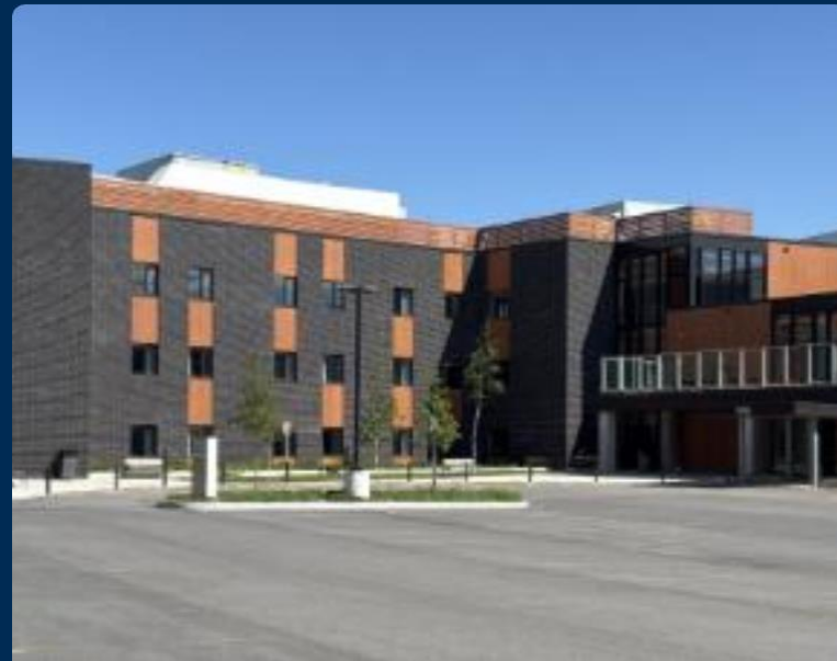
Nouvelle résidence (construction)
